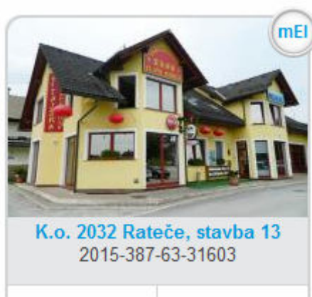
Poslovno-stanovanjski objekt Rateče - Gorenja vas
